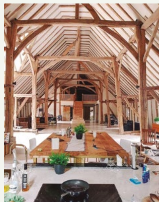
Rénovation d'une grange du 17 ème siècle avec chauffage au sol dans l'Essex (Royaume-Uni). Aquarea
